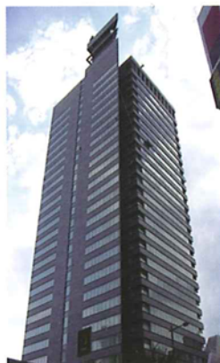
東北電力本店ビル
