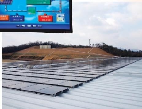
屋根には、太陽光パネル2,600枚、約3,200㎡を設置(発電電力390kW、年間発電量約39万kW)。自己消費電力を賄うことで、二酸化炭素排出量を削減し、低炭素社会の実現に貢献していきます。
