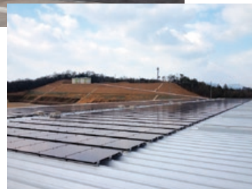
▲屋根に設置した太陽光パネル
