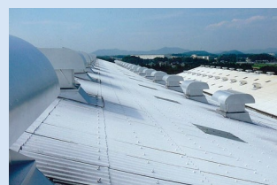
建屋・屋根改修
